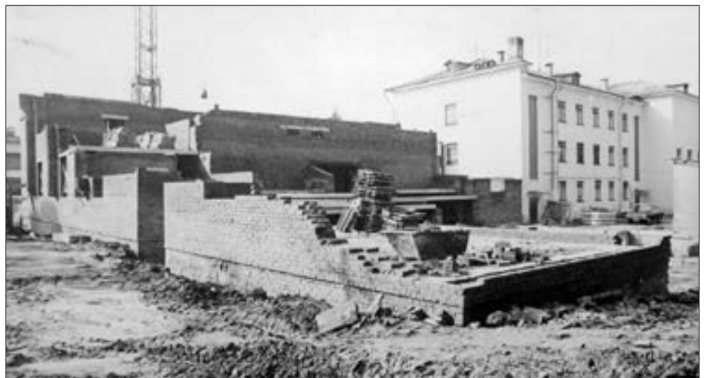
Стройка здания Городского комитета КПСС (ныне ЦТЮ). 1983 г. Прислал Олег Прокошев.
